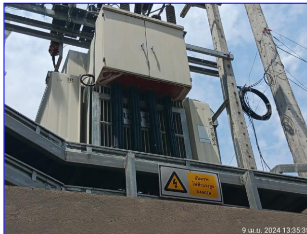
รูปที่ 2.17 หม้อแปลงไฟฟ้า และป้ายเตือนอันตราย
